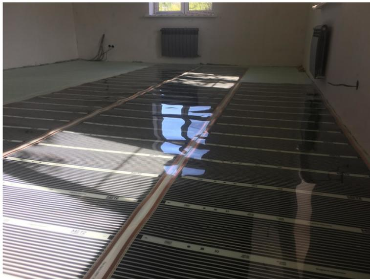
Инфракрасная пленка Ace Floor представляет собой греющие карбоновые полосы соединенные медно-серебряной шиной и покрытые с обеих сторон пленкой из высокотемпературного полиэстера. Пленка имеет дополнительную заземляющую шину и покрыта слоем алюминия, что надежно защищает от поражения электрическим током.
